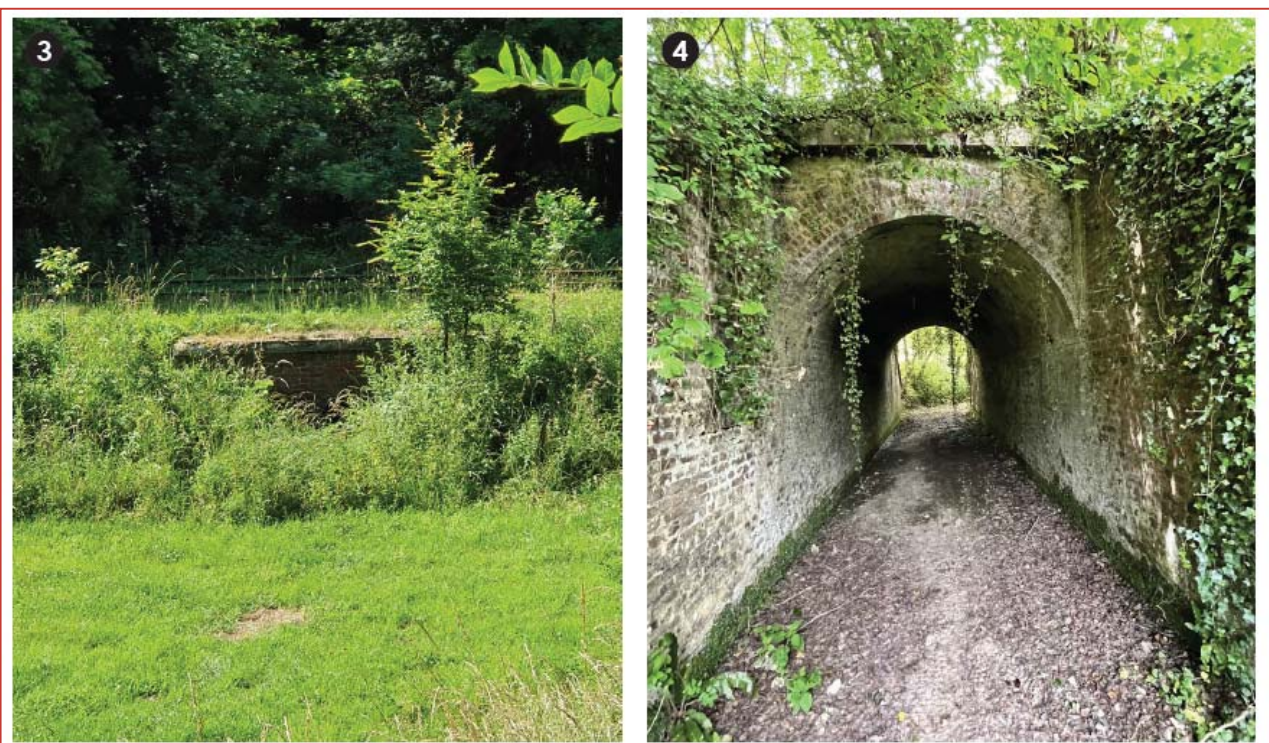
↑ Franchissement des ouvrages pluviaux
