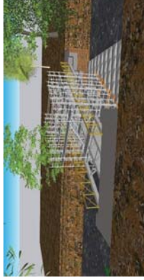
4 – Platelage, échafaudage et confinement Levage de la passerelle existante
