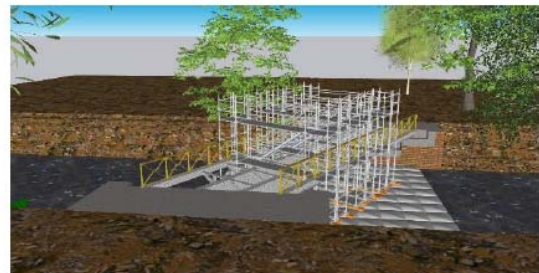
4 – Platelage, échafaudage et confinement Levage de la passerelle existante
