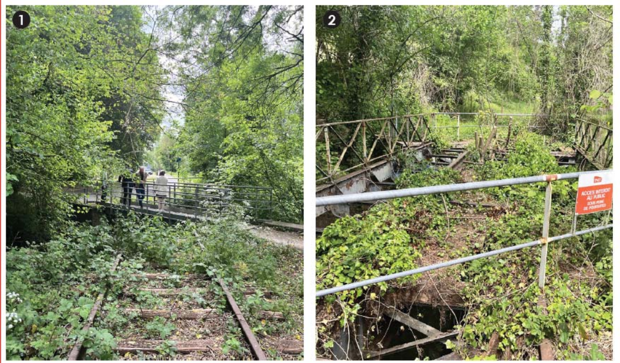
↑ Franchissement de la rivière « Austreberthe »
