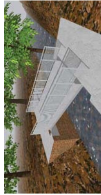
6 – Pose des garde-corps métalliques S8 Raccordements hors ouvrage
