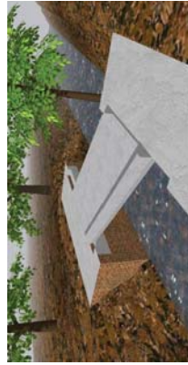
5' - Pose des sections préfabriquées BA Scelllements et clavetages
