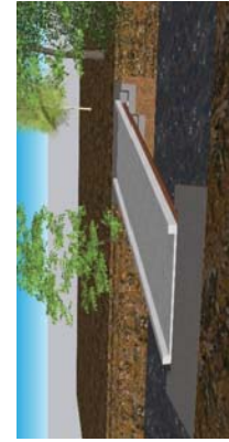
7' – Pose des sections préfabriquées BA Scelllements et clavetages
