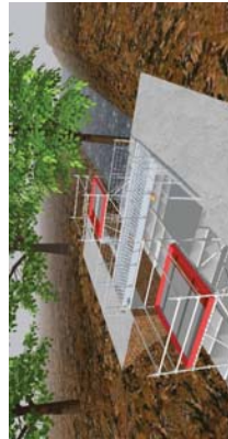
3 – Platelage, échafaudage et confinement Travaux sur culée et appareils d'appui
