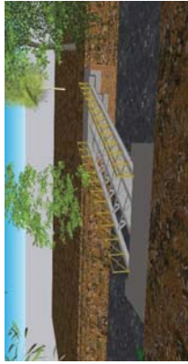
3 – Dépose des rails existants
