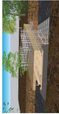
5 – Pose de la passerelle sur des cales provisoires, confinement étanche plomb Dépose des garde-corps existants, sablage, soudure des goujons, application d'un système de peintures multicouche
